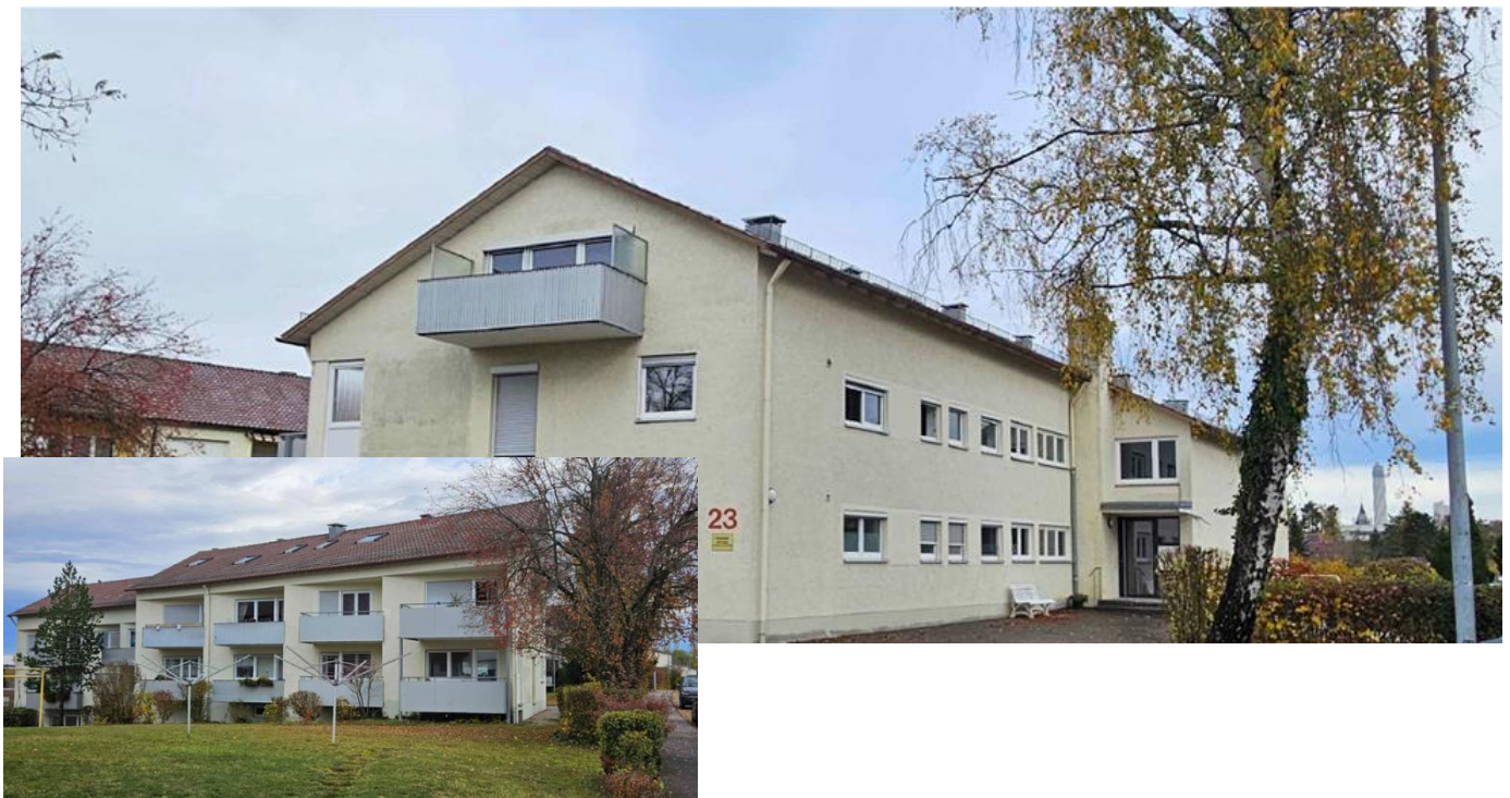
Krummer Weg 23, RW (vor Sanierung)
