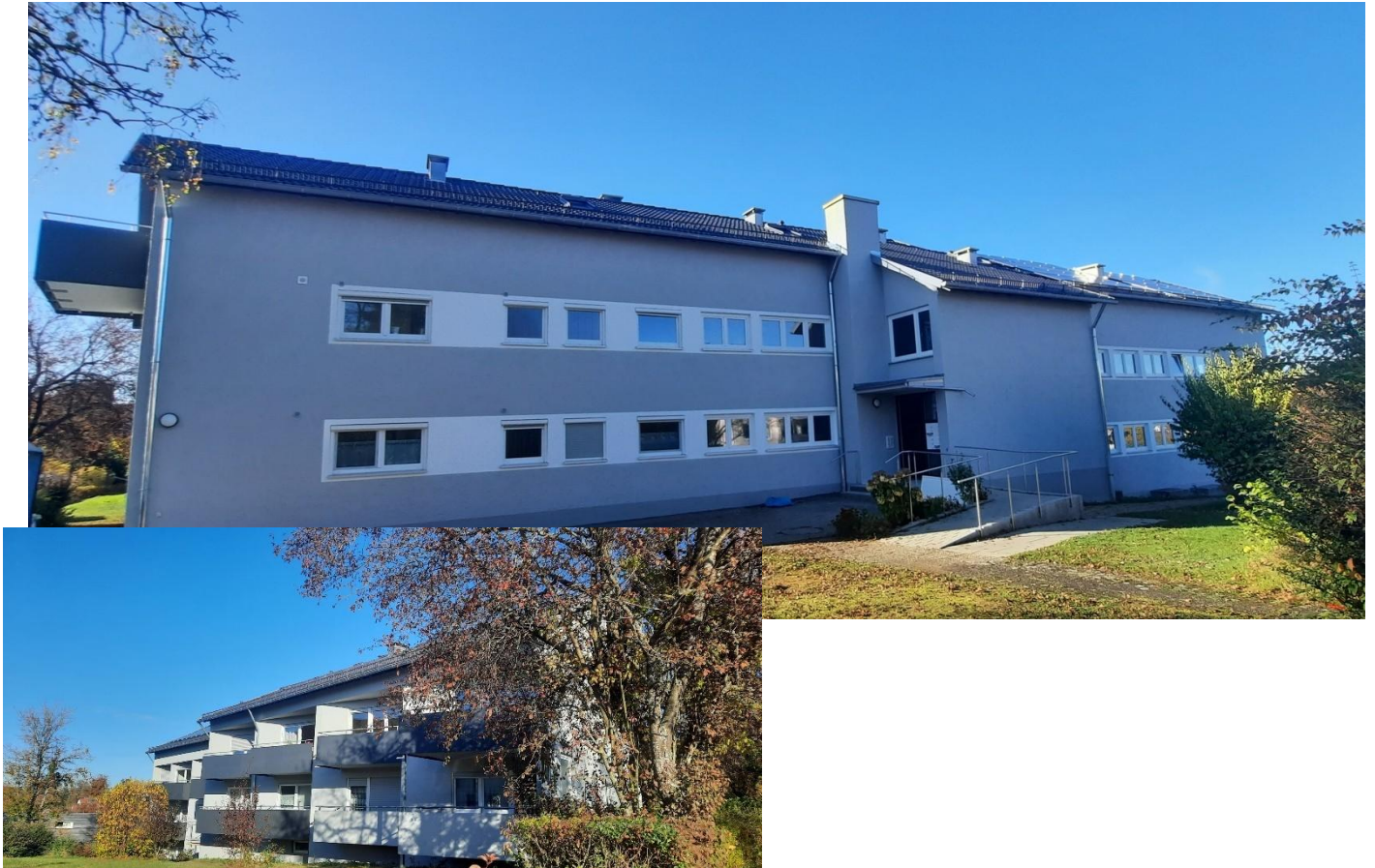
Krummer Weg 23, RW (nach Sanierung)
